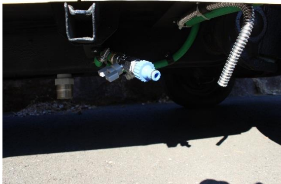
● 排水口、水道直結口
