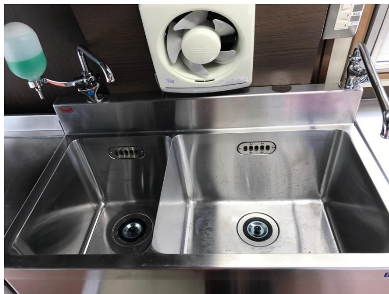
● ステンレス製 二層式シンク (280X360、450X360 D250)
