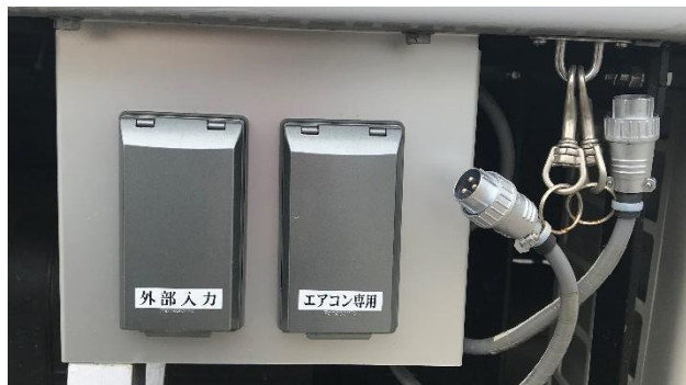
●外部電源引き込み口 (100V 1500w+エアコン用)
